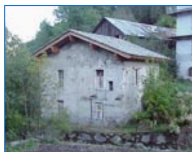
Le centrale Bertin.
