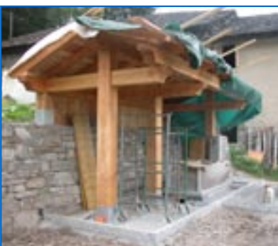
Travaux à La Lavanche.
