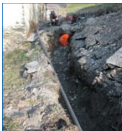
Eternod-dessous: travaux sur l'acqueduc.
