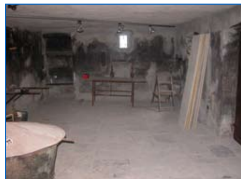
Travaux à la laiterie du Bourg.
