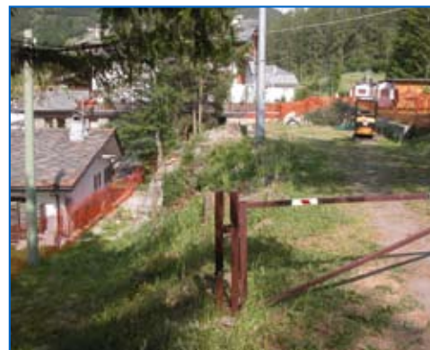
Travaux au Camping Tunnel.
