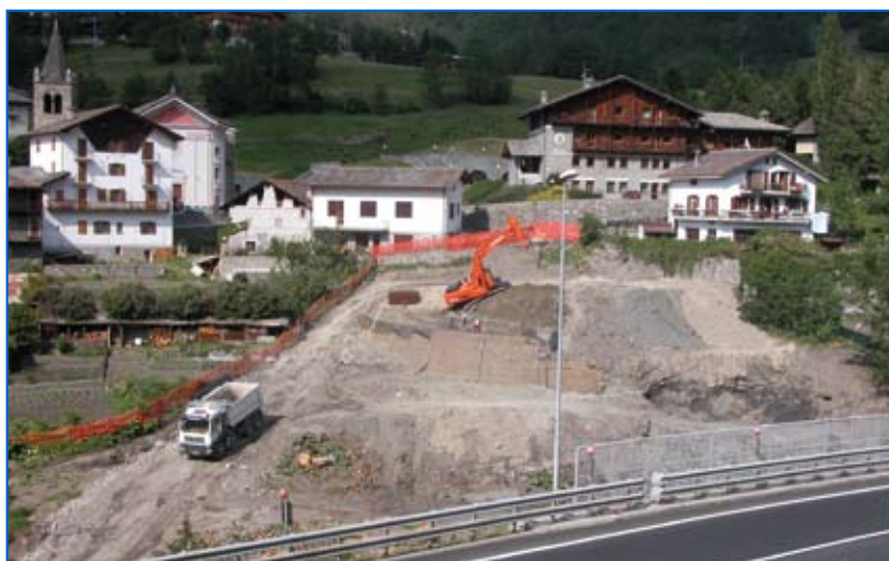
Travaux de construction de la nouvelle route du Bourg.
