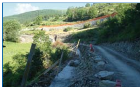
Travaux sur la route de La Côtà.
